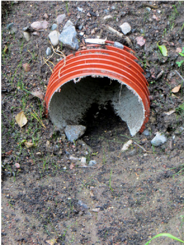
PVC-rör. I det här fallet har röret förstärkts med en veckad struktur på utsidan.
