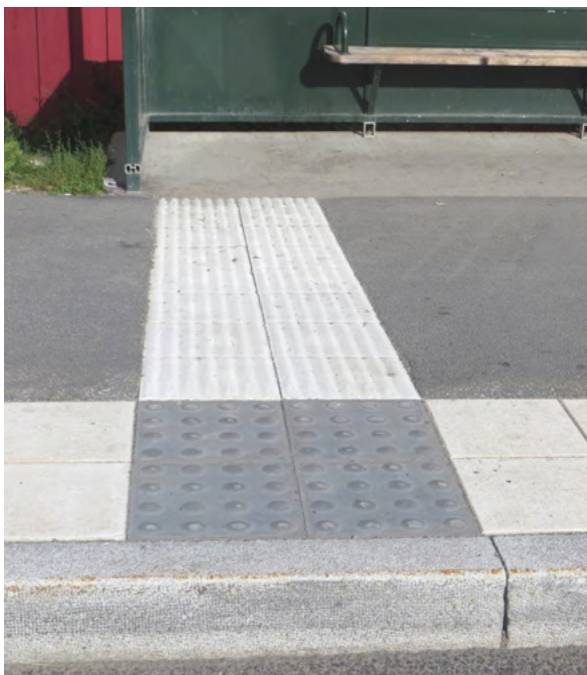
Mönstret i underlagsplattorna hjälper synskadade att orientera sig. Bussen skall stanna så att dörren öppnas mitt framför kupolplattorna.
