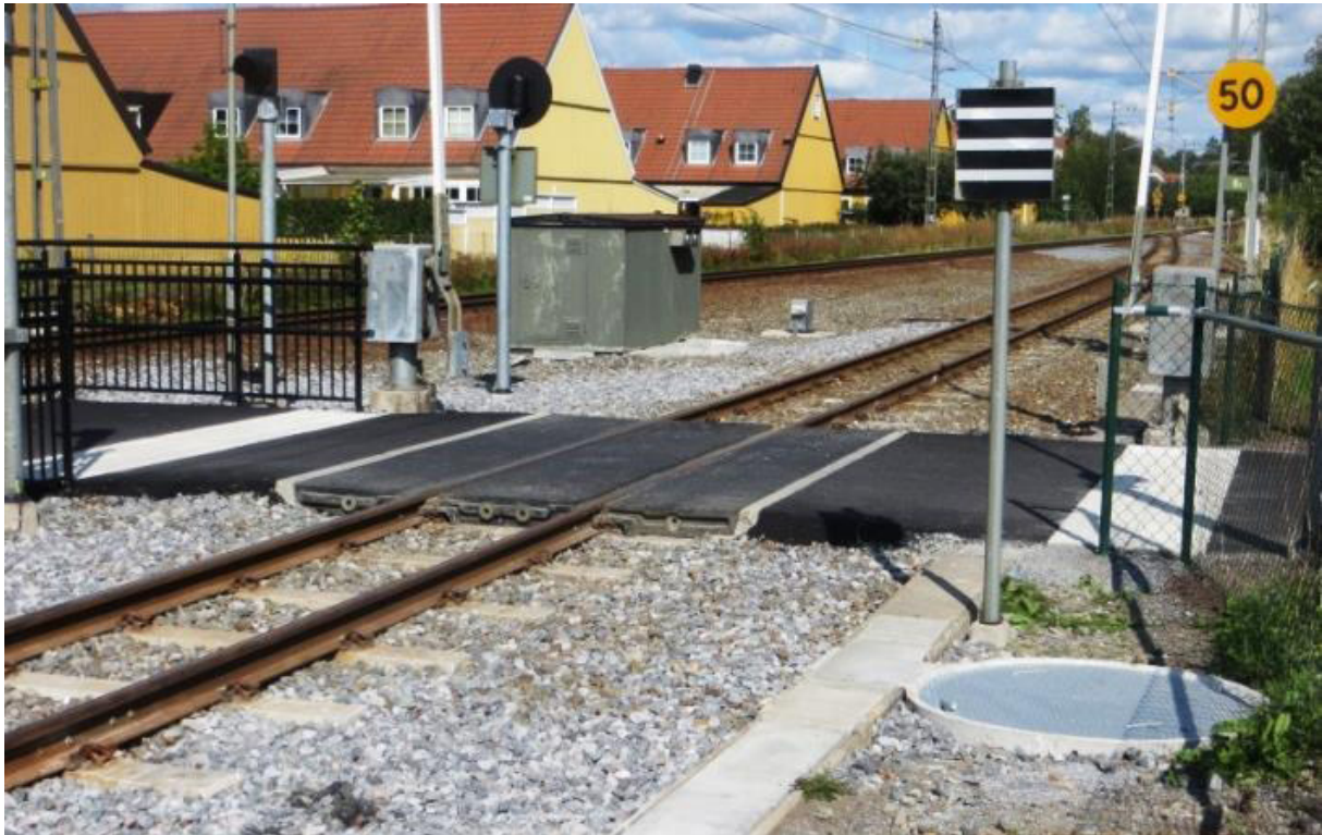
Den svartvita skylten signalerar att loket som plogar spåren måste lyfta på plogen för att inte skada överfarten.
