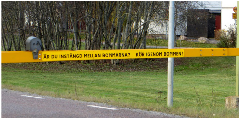
Texten på järnvägsbommen avslöjar tanken med bommens konstruktion.
