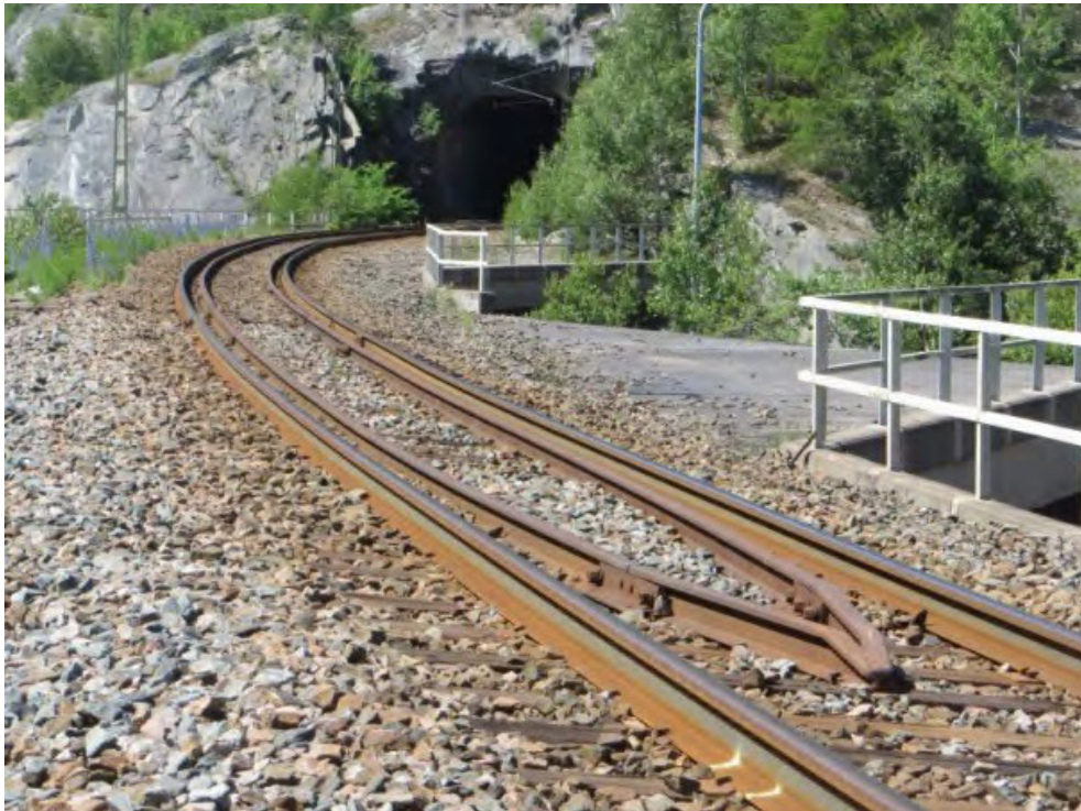
Banvall med makadam. Notera också förekomsten av så kallade säkerhetsreläer eller skyddsreläer innanför de ordinarie rälererna, som avser att hålla kvar urspårade järnvägshjul på banvallen. De används på broar och vid tunnlar, där det är speciellt allvarligt om urspårade vagnar välter.
