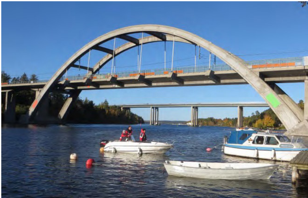
Två broar av betong vid Stäket, Järfälla. Bågbron närmast kameran är en järnvägsbro. I bakgrunden syns en balkbro på pelare för fyra körfält på E18.
