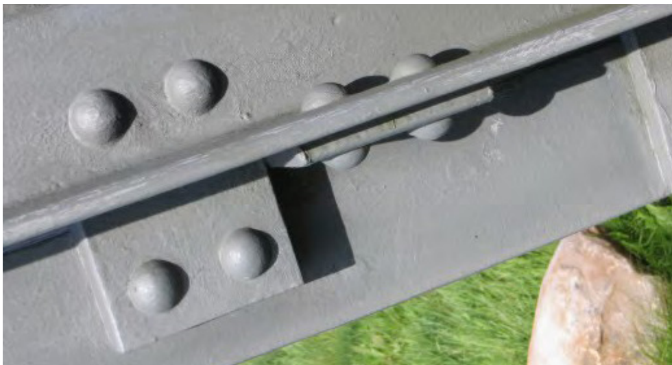
Nitförband i radiomasterna i långvågssändaren i Grimeton i Halland, från 1920-talet och nu ett av Sveriges världsarv.
