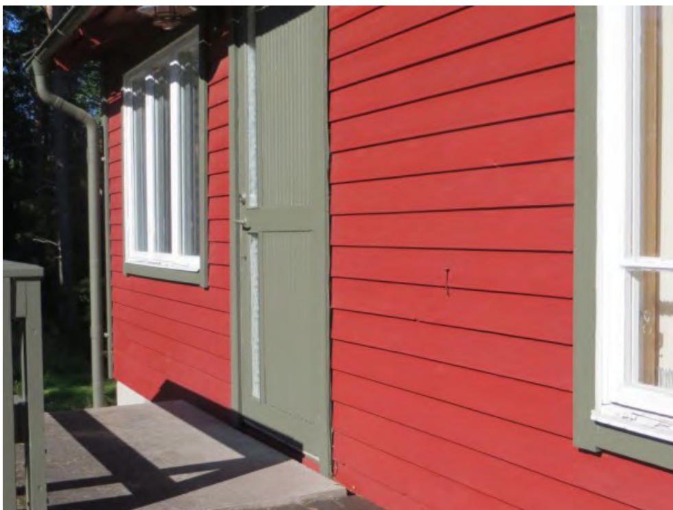
Fasadbrädorna är lagda horisontellt enligt taktegelprincipen för att skydda mot regn.
