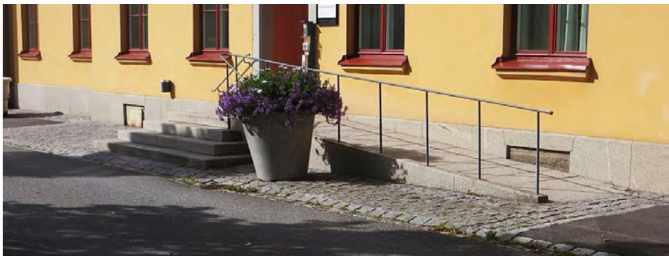
En ramp underlättar för den som inte kan gå i trappor.
