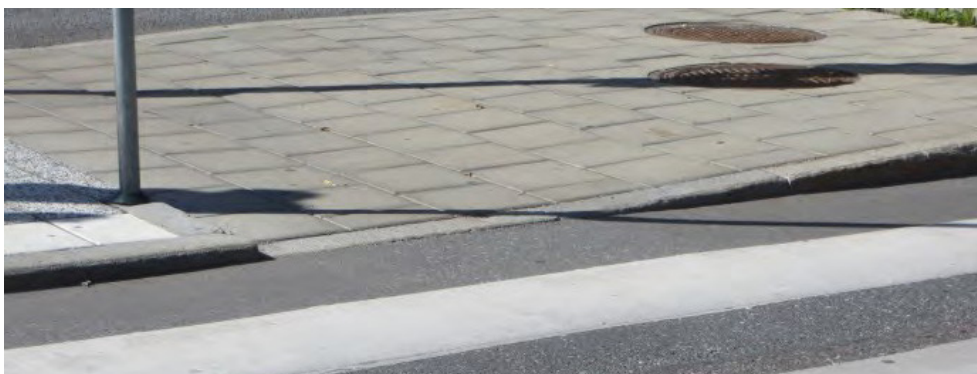
Avfasad trottoarkant vid övergångsställe.
