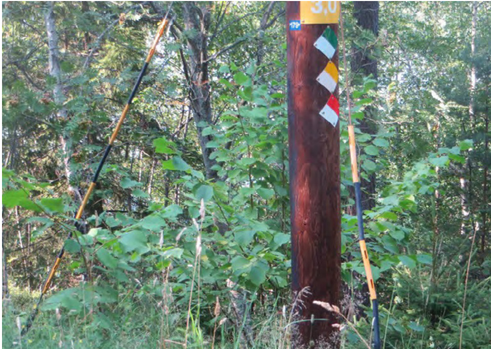
Stagen till ledningsstolpen har en gul-svart markering för att de skall synas tydligare så att man inte råkar gå på dem. Notera också skyltarna för olika långa.
