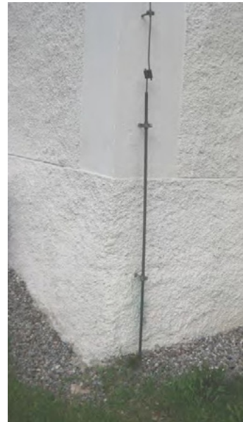
Åskledare är särskilt vanligt på kyrkor. Här går en åskledare i Täby kyrka ner i marken.
