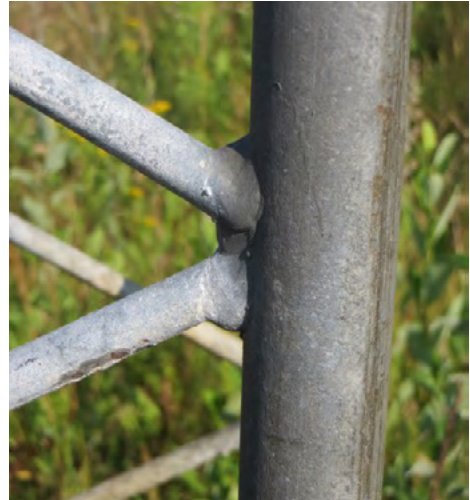
En fackverkskonstruktion där delarna svetsas ihop.
