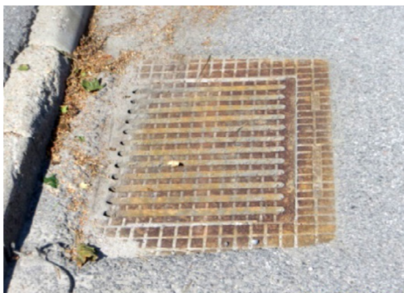
Rektangulärt lock för rännstensbrunn och kupolformat lock (kupolsil) för dike.
