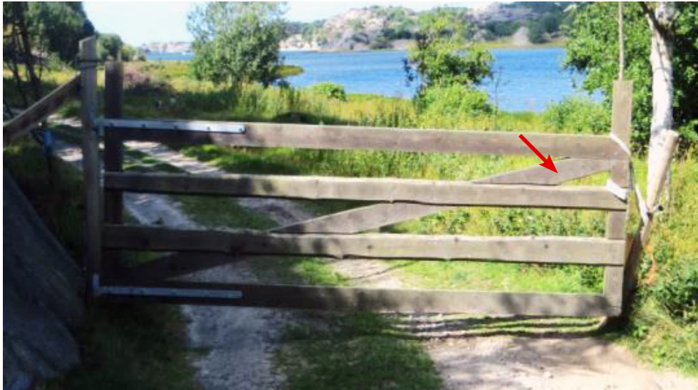
Den diagonala plankan vid pilen förstärker grinden.
