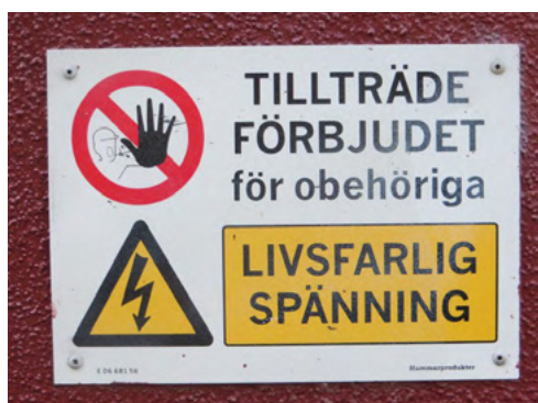
Skyltar på utsidan av en byggnad som hör till elnätet.
